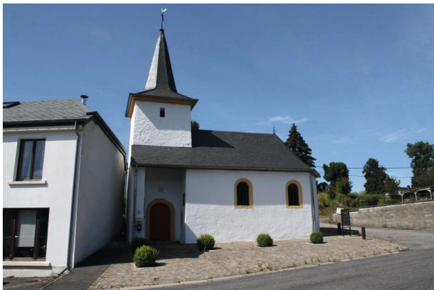
La chapelle de Grumelange (1700) après rénovation
